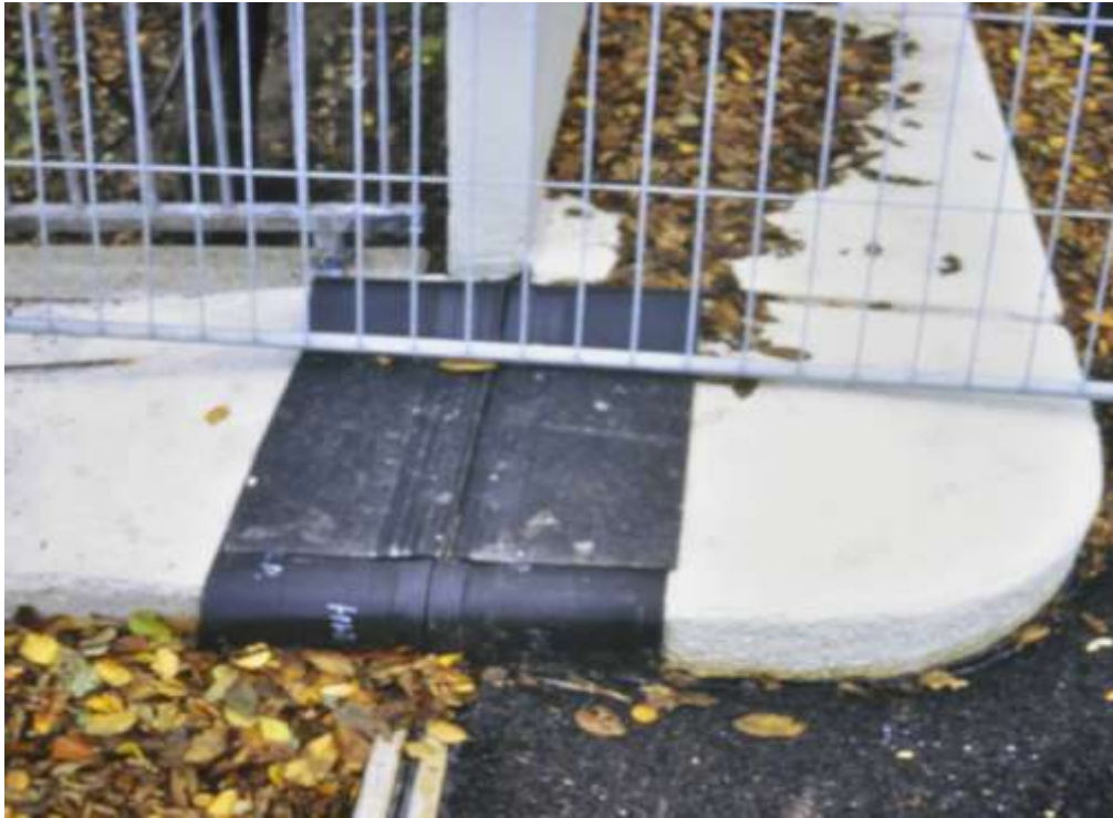
F12 - Weiterführung der Dehnungsfugenprofile – Sonderlösung um „Stolperfallen“ zu vermeiden und eingebettet in die Oberflächenbeschichtung der Schrammboarde, der Brüstungen
