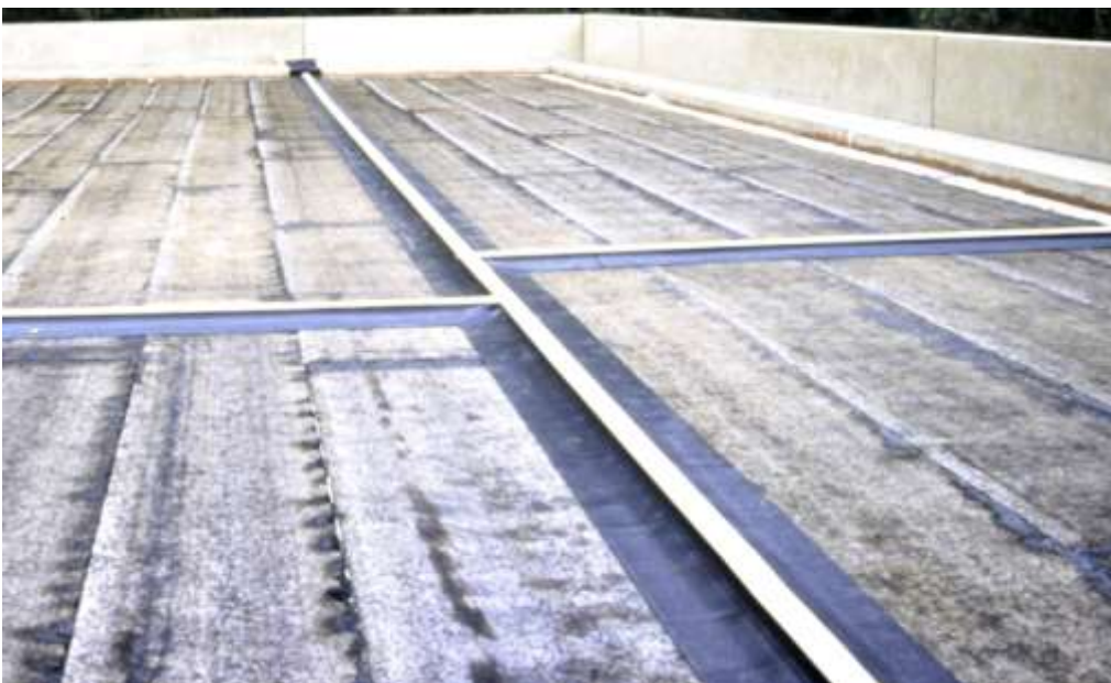
F11- Neu eingebrachte Schutzschicht mit Kunstharzmörtel, Epoxidbeschichtung, Abdichtung, aus Bitumenbahnen und den Dehnungsfugenprofilen.
