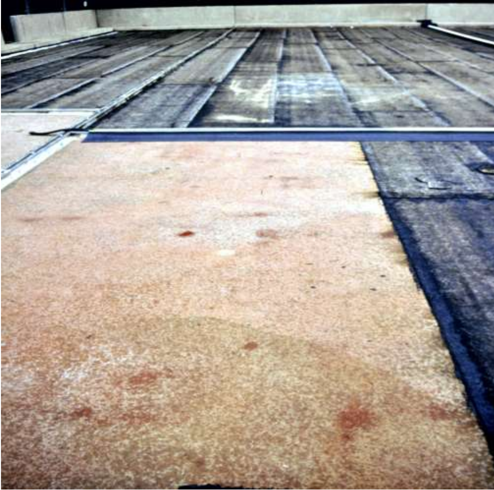
F11- Neu eingebrachte Schutzschicht mit Kunstharzmörtel, Epoxidbeschichtung, Abdichtung, aus Bitumenbahnen und den Dehnungsfugenprofilen.
