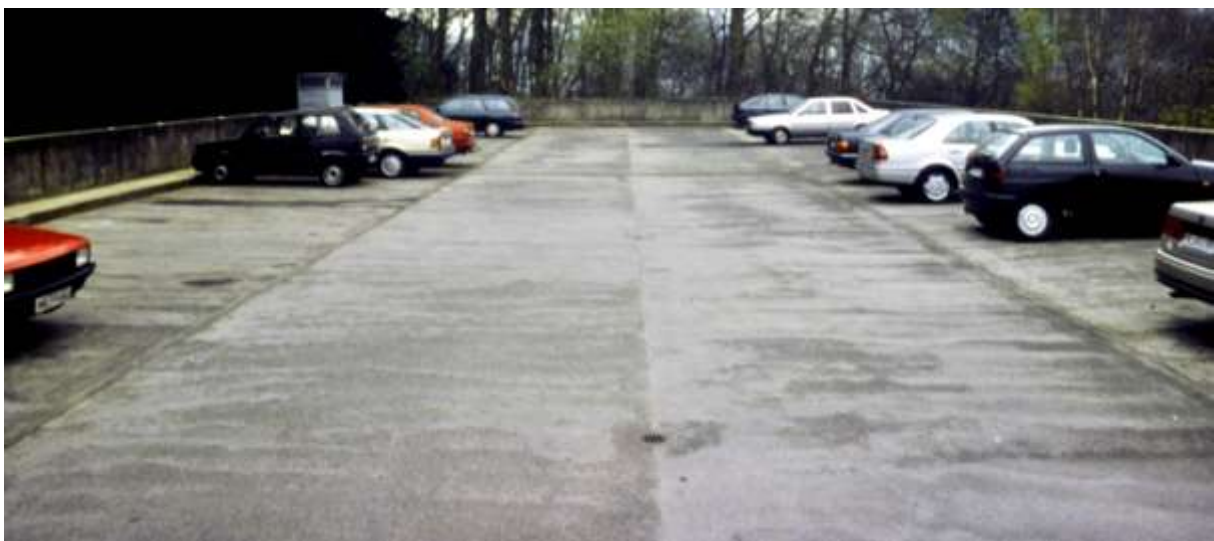
F08 - Ansicht des oberen Parkdecks aus den 70er Jahren - von der Zufahrt
