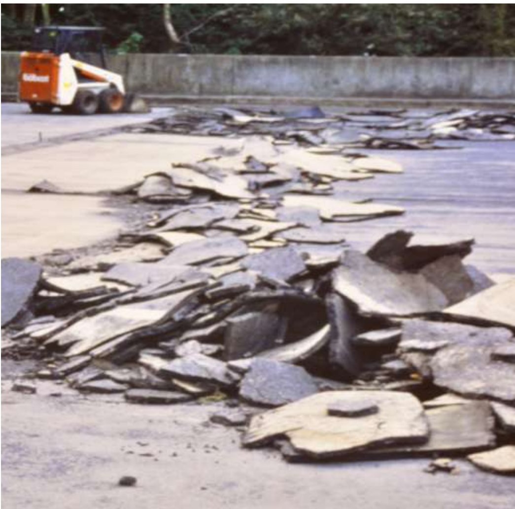
F10 - Abriss der vorhandenen Gussasphaltschicht und Teilen des Schutzbelags (Beton) bis auf die tragende Betonschale
