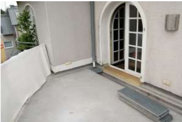
Abb. 12: Balkonsanierung mit Flüssigkunststoff und gezielter Entwässerung (Foto: Lech)
